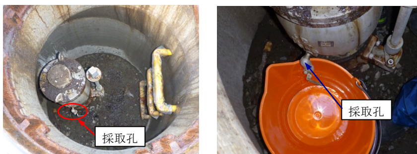
写真 5-1 空気弁の採取孔設置状況の一例
