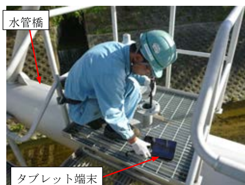
写真 5-11 デジタルカメラ調査状況（水管橋での調査）
