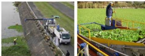
図-10 機械や清掃船による回収
