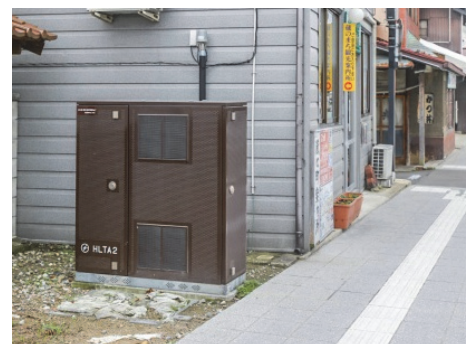
電線地中化における地上機器の路外配置
