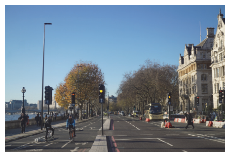
歩道・車道と分離された安全な自転車専用道路 (イギリス・ロンドン)
