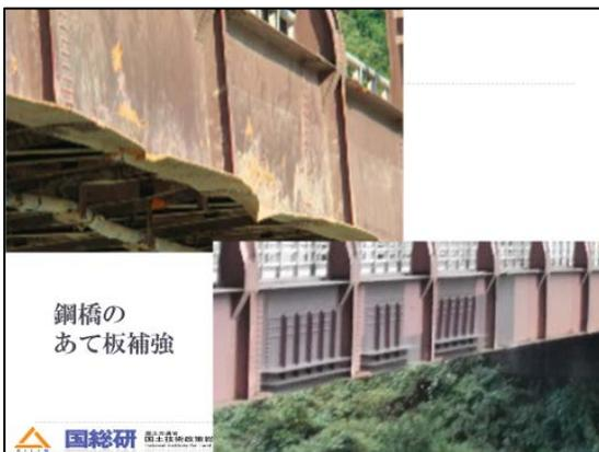
補修・補強について。この写真も下から撮影していますね。鋼橋の主桁において、既設部材に鋼板を当てて補強しています。その場合の設計法についての事例です。
