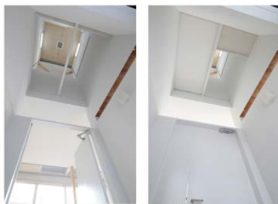
換気塔(玄関上部)
