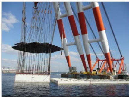
既存の防波堤が支障となる狭隘な場所でのケーソン据付: 神戸港
