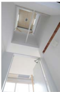
換気塔(玄関上部)
