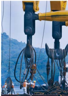
宇和島港における巨大クレーンの玉掛け作業
