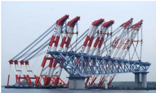
大型起重機船3隻相吊りによる大ブロック架設:東京ゲートブリッジ
