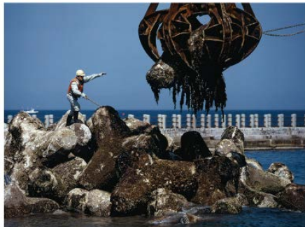
新潟西海岸における老朽化した消波ブロックの撤去状況
