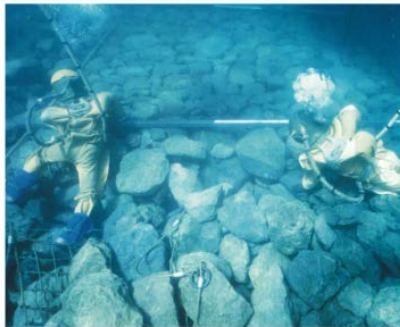
水中作業(水中溶接、ブロック据付、均し作業等)は潜水士が全て行う。
