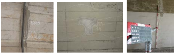
(a) 断面修復工 (b) 表面保護工 図-3 補修箇所の再劣化の例(カルバート)
