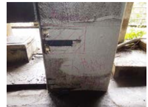
(a) 断面修復工(谷側柱)
