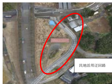
写真1 道路用地以外を迂回路として整備した事例
