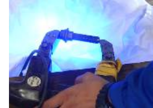
(b) ボルトの磁粉探傷試験
