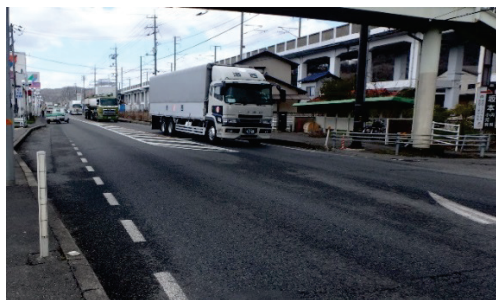
写真1 評価1と判定された筒所の舗装
