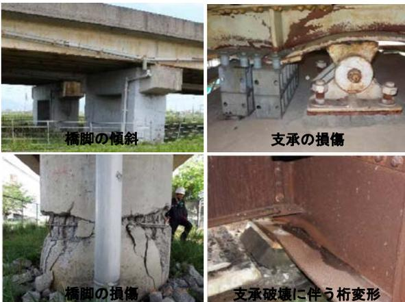
図-2 熊本地震における道路橋の特徴的な被害 (H28.6.24第5回道路技術小委員会配布資料より引用)
