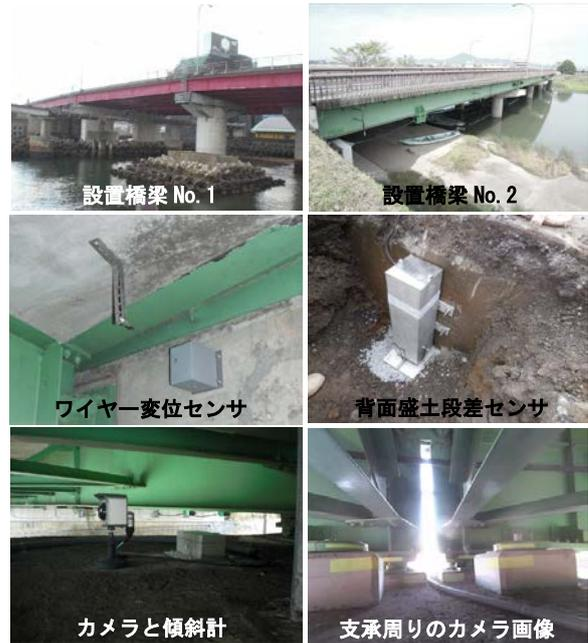
図-4 道路橋被災状況把握システムの設置状況
