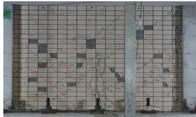
No. 4 直張り・深目地
