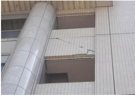
写真 2.3 柱および壁に拘束された腰壁のせん断ひび割れのせん断ひび割れ
