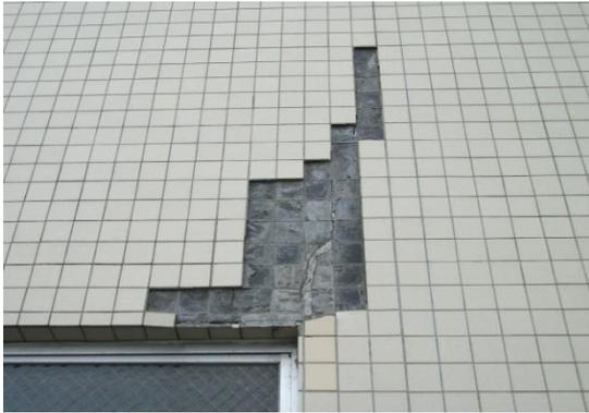
写真 2.19 開口部周辺の剥落（開口隅角部
