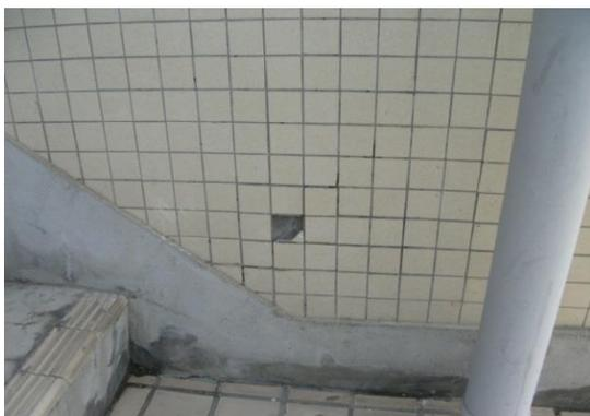
写真 2.7 外階段壁のせん断ひび割れおよび欠損
