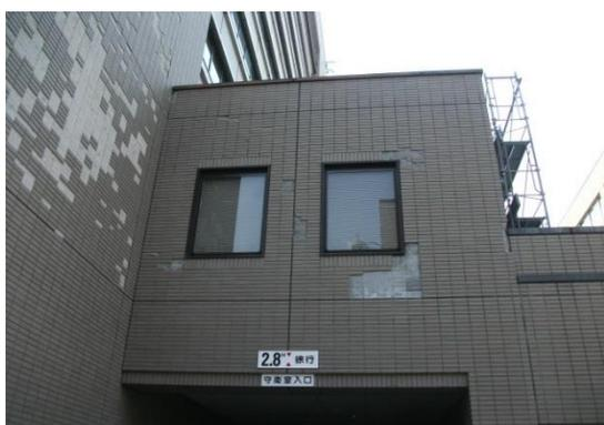
写真 2.17 開口隅角部で剥落（躯体コンクリートと下地モルタルの接着面で剥離）
