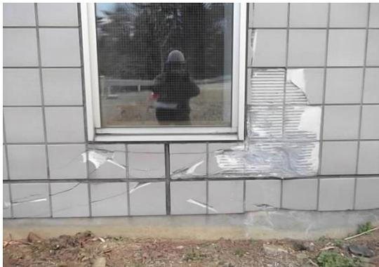
写真 2.5 開口隅角部のせん断ひび割れとタイル裏足剥落
