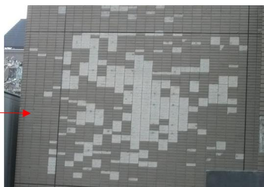
写真 2.16 タイル裏足と張付モルタルの接着面で剥離
