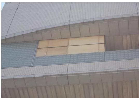
写真 2.25 ガラスブロックの破損
