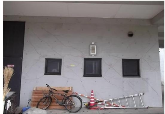
写真 2.4 窓と窓の間の壁のせん断ひび割れ (モルタル塗仕上げ)
