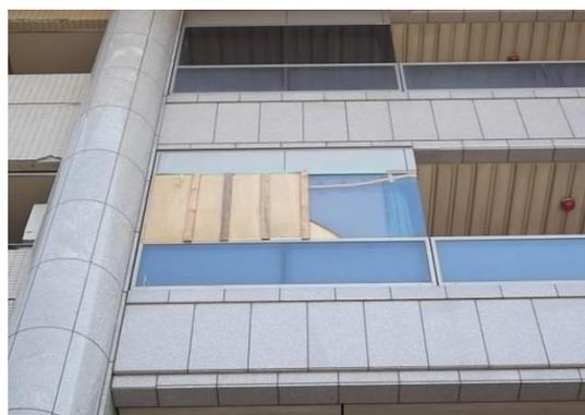
写真 2.26 はめ殺し窓のガラス破損
