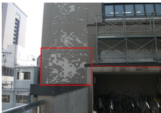
写真 2.15 窓のない壁面で剥落（叩き落としを含む）
