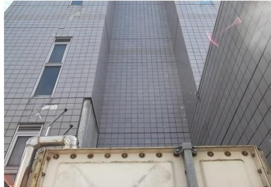
写真 2.20 形状が複雑な壁面で剥落（躯体
