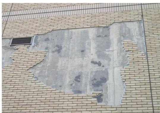
写真 2.18 無窓の壁面で剥落（躯体コンクリートと下地モルタルの接着面で剥離）
