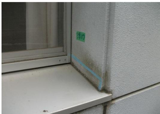
写真 2.14 水切り板周辺のモルタル塗仕上げ浮き
