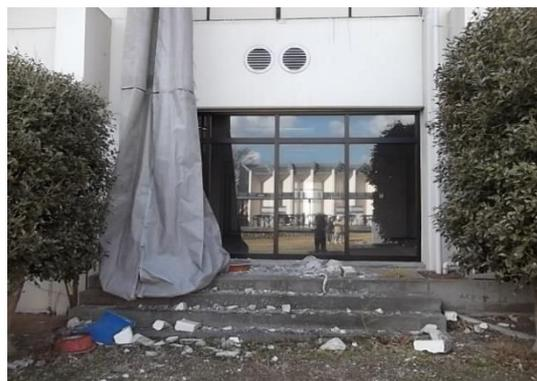
写真 2.12 欠損落下したコンクリート
