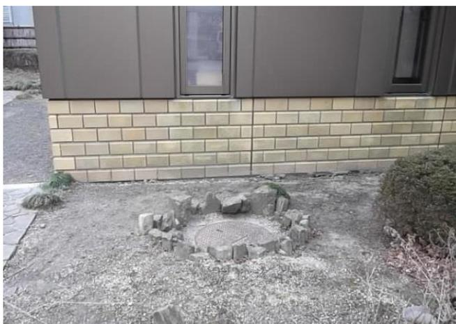
写真 2.22 沈下した地面
