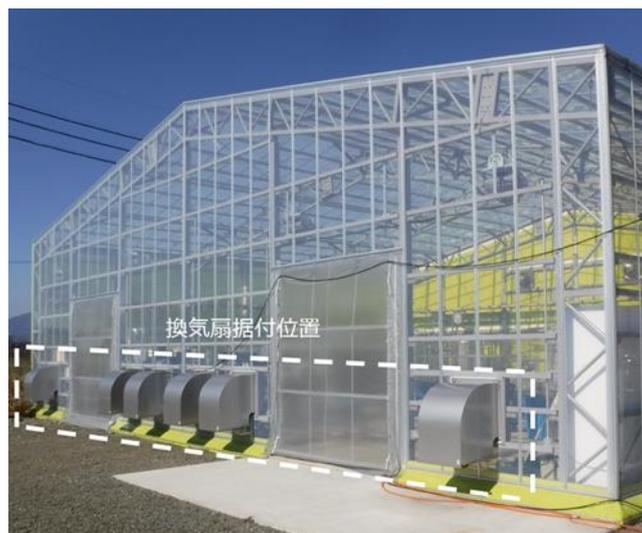
図 4-8 実証研究における換気扇の設置状況 (例)
