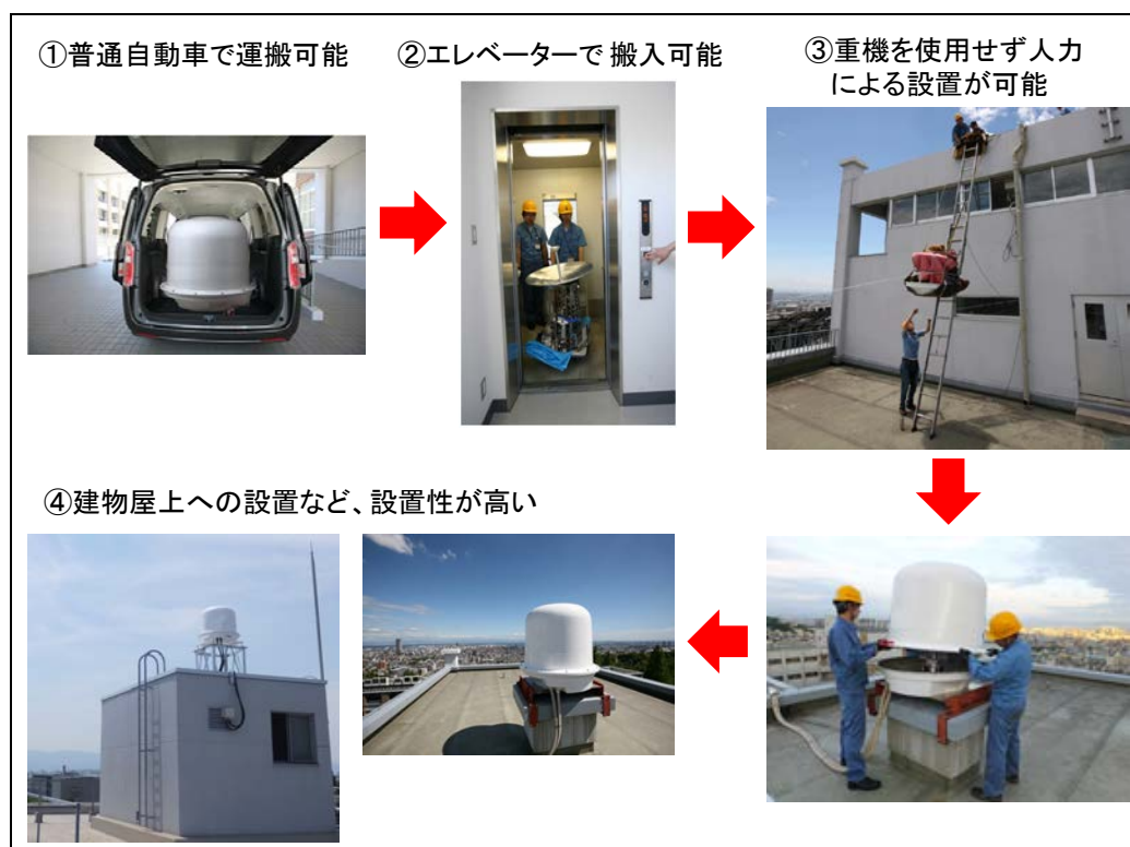
図 3-5 スペースの限られた建物屋上への設置例
