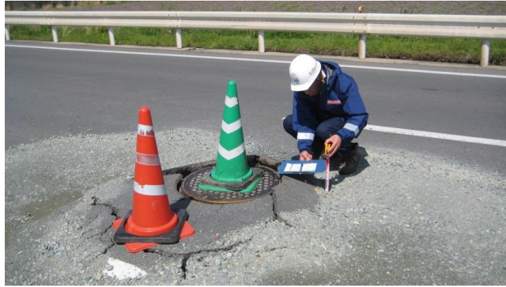
付録写真-5 秋津川沿いのマンホール調査状況
