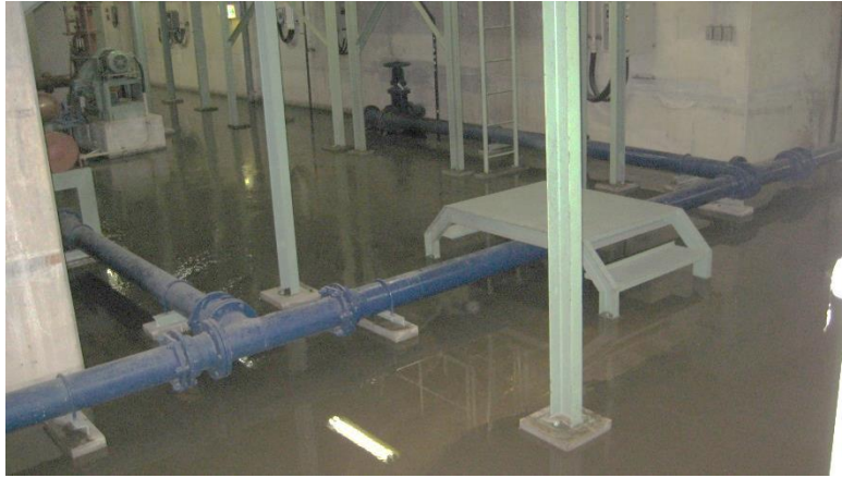
付録写真-4 益城町浄化センターの管廊の浸水状況
