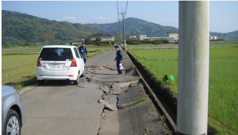
付録写真-1 益城町浄化センター前の幹線管渠上の路面状況 (写真奥が浄化センター)
