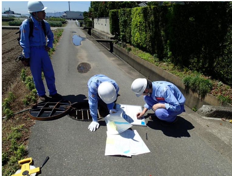
付録写真－10 熊本市西区中原町における調査風景
