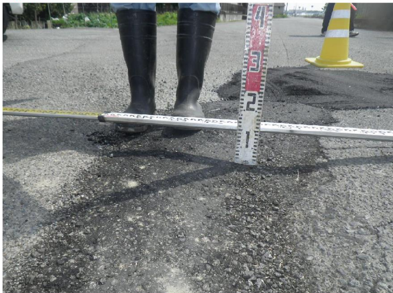
写真－10 マンホール部人孔浮上状況（災害査定資料より）
