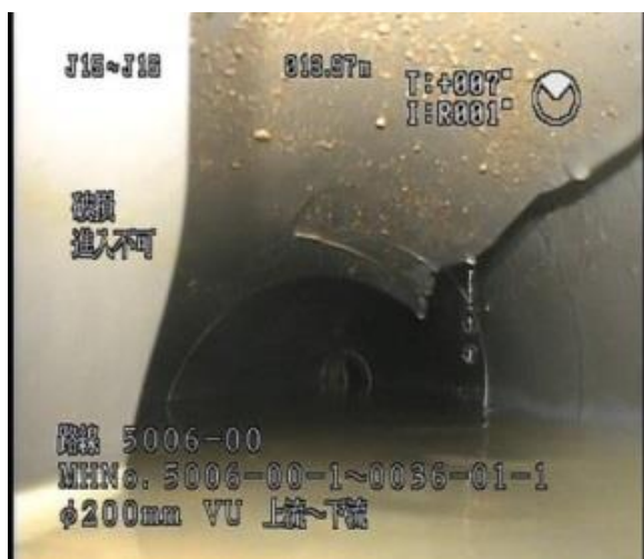
写真-6 塩ビ管の破損①(益城町)
