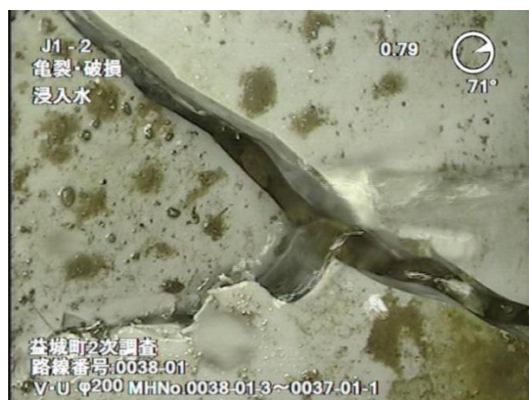
写真-8 塩ビ管の破損③(益城町)
