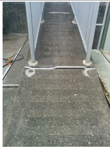
写真 36 : 益城町浄化センター反応槽 EXP. Jズレ (4月16日)
