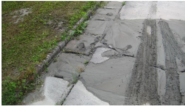
写真 31 : 益城町浄化センター場内 (4月16日)
