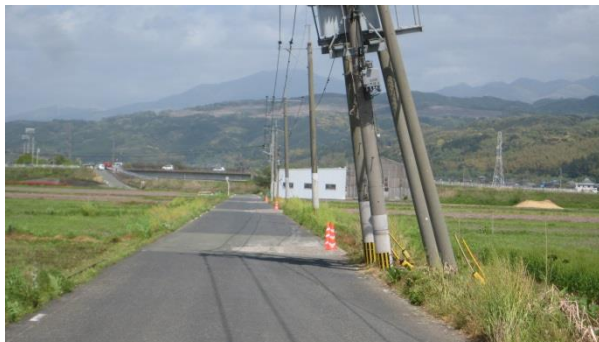
写真 11 : 益城町東部污水管線 (4月17日)
