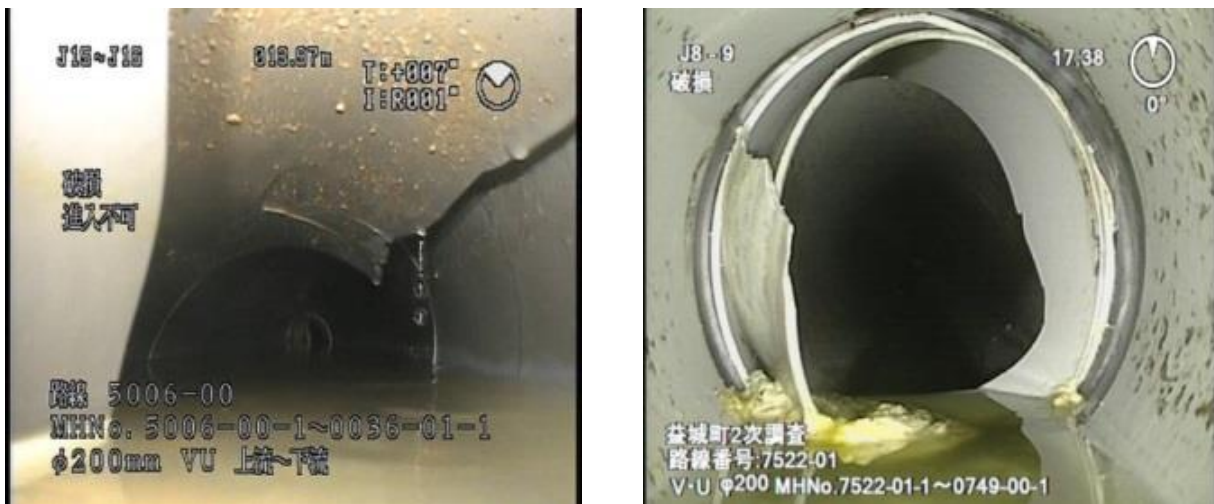
写真-5 塩ビ管の破損（益城町）
