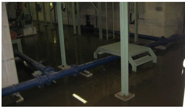
写真 37 : 城町浄化センター管廊浸水 (4 月 16 日)
