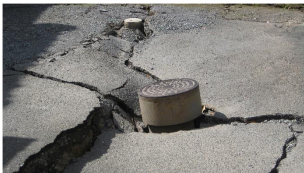
写真 21 : 益城町惣領秋津川橋上流側右岸 (4月17日)
