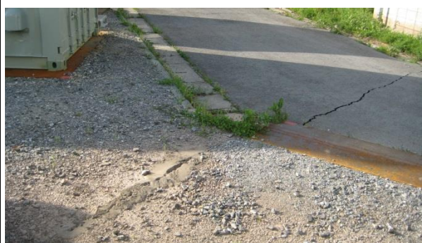
写真 29 : 益城町浄化センター場内 (4月15日)
