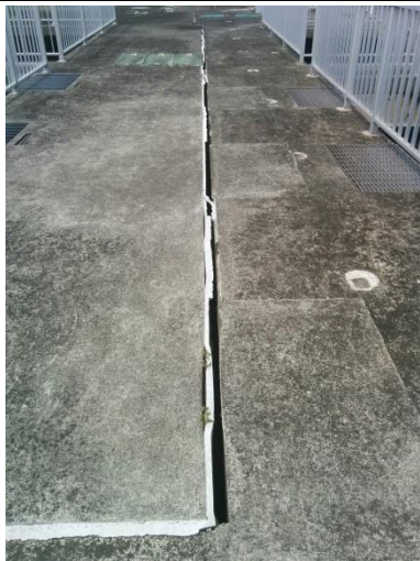
写真 35 : 益城町浄化センター反応槽 EXP. Jズレ (4月16日)
