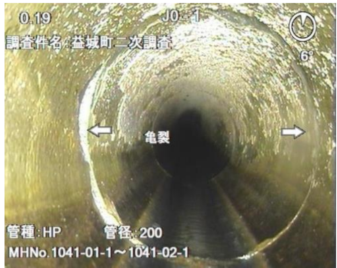
写真-2 コンクリート管の円周方向クラック（益城町）
