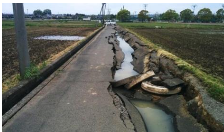
付録写真-3 開削工法埋め戻し部の陥没（益城町）
