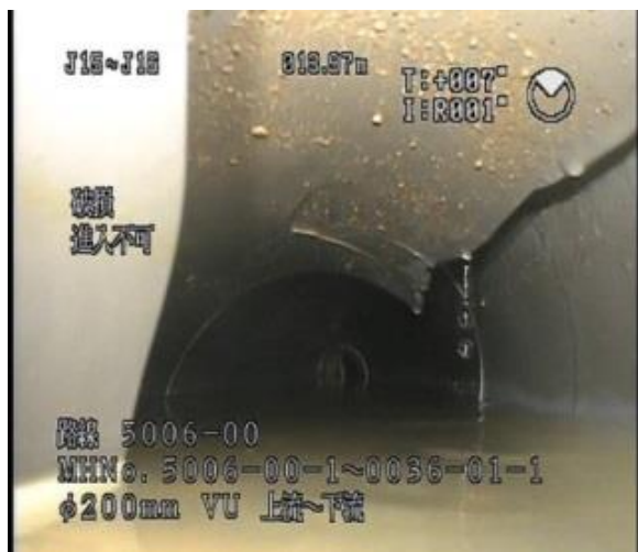
写真-6 塩ビ管の破損①(益城町)
