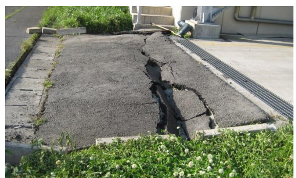
写真 28 : 益城町浄化センターホッパー室入口 (4月15日)
