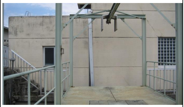
写真 34 : 益城町浄化センター水処理棟 EXP. Jズレ (4月16日)
