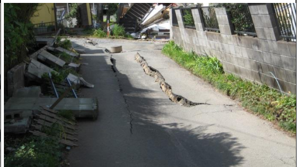
写真 20 : 益城町惣領秋津川橋上流側右岸 (4月17日)
