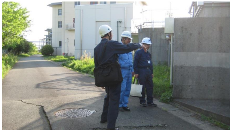
付録写真-2 益城町浄化センター内の被災状況を確認 (手前：内田下水道機能復旧研究官)
