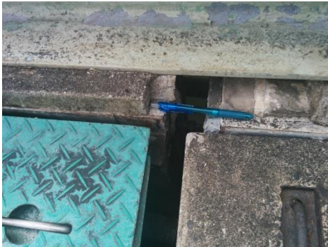
写真 33 : 益城町浄化センター反応槽 EXP. Jズレ (4月16日)
