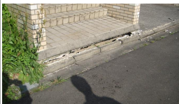
写真 27 : 益城町浄化センター管理棟 (4月15日)
