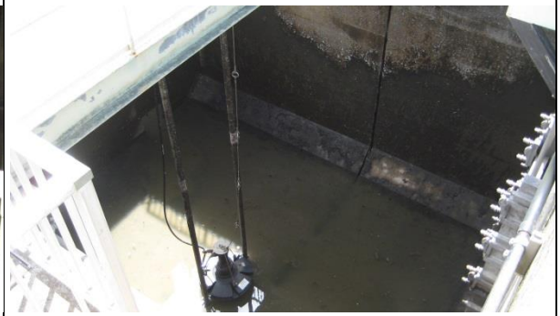
写真 38 : 益城町浄化センター反応槽 (4 月 17 日)
