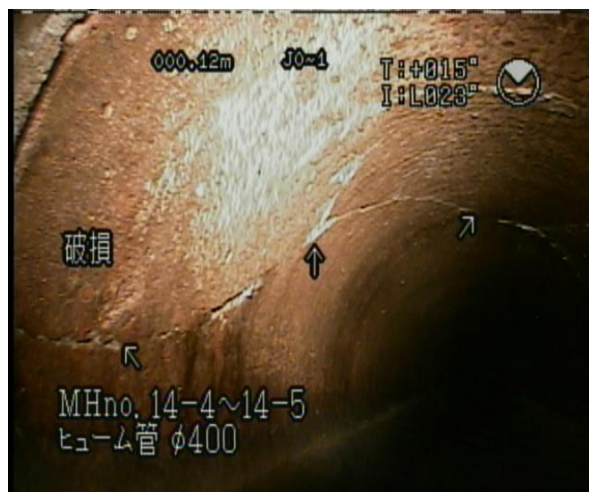
写真-1 コンクリート管の破損（宇土市）
