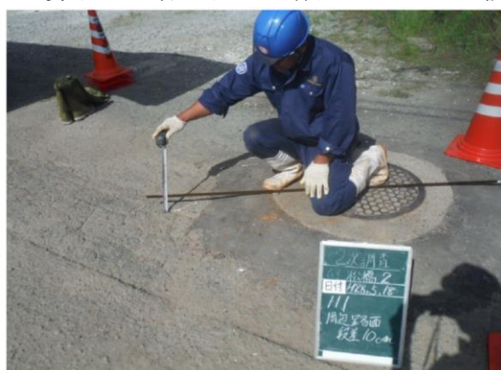
写真-11 マンホール部人孔浮上状況（災害査定資料より）
