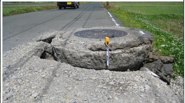
写真 12 : 益城町東部污水管線 (4月17日)
