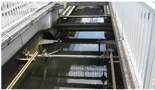
写真 39 : 益城町浄化センター最初沈殿池 (4 月 17 日)
