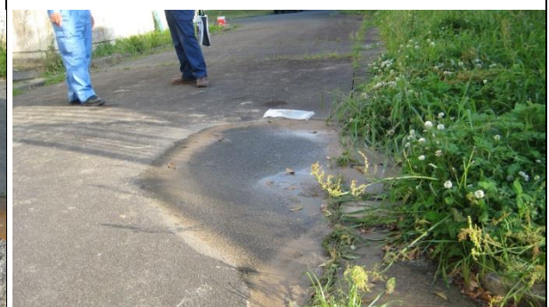
写真 30 : 益城町浄化センター場内 (4月15日)
