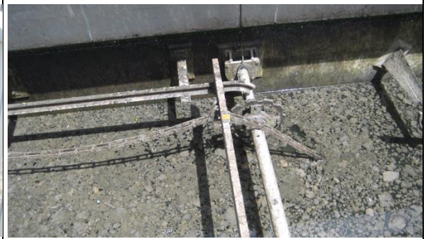
写真 40 : 益城町浄化センター最初沈殿池 (4 月 17 日)
