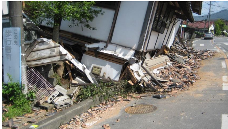
付録写真-6 家屋倒壊の激しい益城町県道 235 惣領のマンホール
