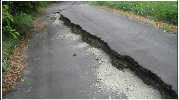
写真 32 : 益城町浄化センター場内 (4月16日)
