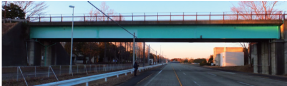
図-4.3.1 実験対象橋梁（側面写真）
