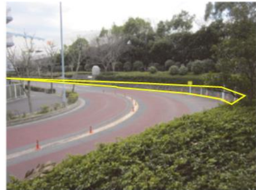
図-2.5 旧海岸堤防（黄枠）を分離帯として活用した例
