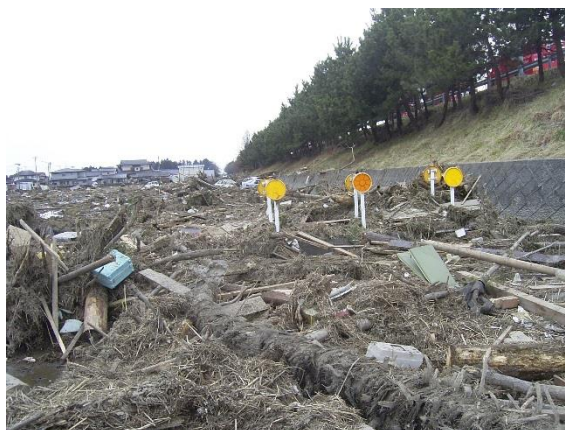
写真-1.1 東北地方太平洋沖地震直後の仙台東部道路の海側の状況
