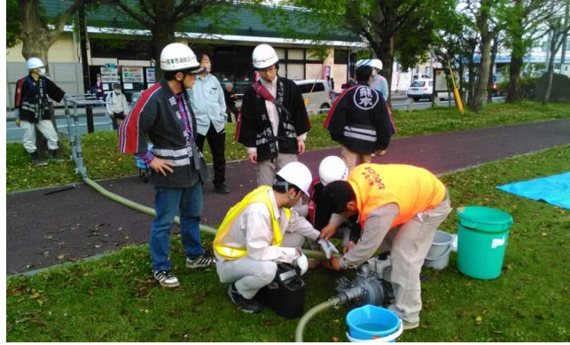
図Ⅳ－４ 震災時に公園管理者が耐震性貯水槽の運用のサポートを実施した例（熊本市錦ヶ丘公園）
