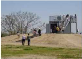
【備蓄倉庫付き展望台】
