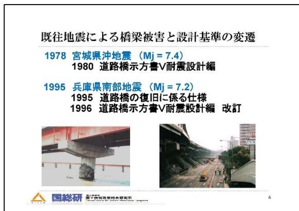
宮城県沖地震では橋脚の段落とし部でこういう甚大な被害が生じまして、1990年の基準では橋脚設計法として地震時保有水平耐力法を取り入れ、プレート境界型の1Gの水平震度に対して持たせるような設計としています。ただ、そのとき基礎は地震時保有水平耐力の設計は行っておらず、橋脚だけ1Gに対する設計をしております。
