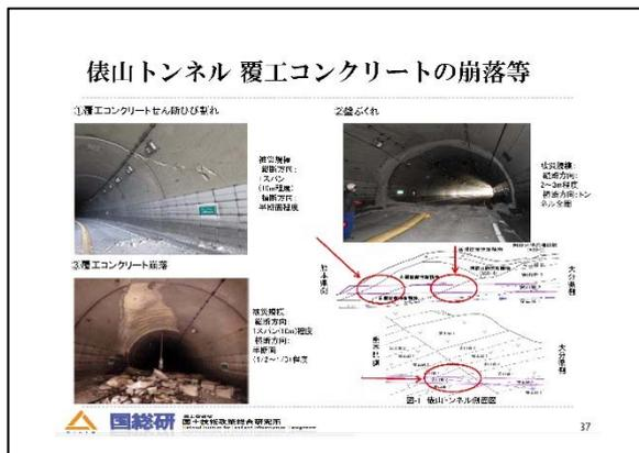
俵山トンネルで、大きな斜めのひび割れ、覆工コンクリートの崩落、あるいは、全体の座屈の様なことが生じております。こちらについては、横方向、断面方向に変形したのでしょうか。こちらはトンネルの軸方向に大きく変形したと思います。なぜこの場所で変形して、なぜ他が変形しなかったのかということ調べてみますと、地山が関わっております。もともと山が弱い所でこういう被害が起きたということでございます。覆工が大きく剥落した所では、現在、復旧工事を行っており、もうじき供用できると思いますけれど、その覆工工事のときにはがしてみますと、鋼のアーチの支保工が座屈するという現象が起こっております。局所的にこの部分はかなり大きく揺れたことが見てとれます。
