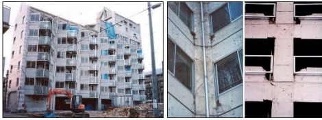
倒壊は免れ人命を守ったが、柱・はり・柱はり接合部の損傷が極めて大きく、その修復費用が莫大であったため取り壊され建て直された
