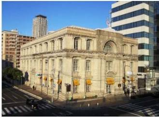
神戸郵船ビル (1916竣工 RC&SC+4)
