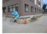
写真: 液状化発生により建物周りの地盤沈下が認められたM液状化。
