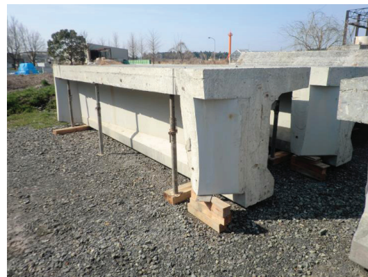
写真-4.3.1 供試体設置状況（G 橋）
