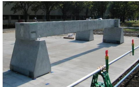
写真-3.2.1 模擬損傷供試体（D-1、D-2）
