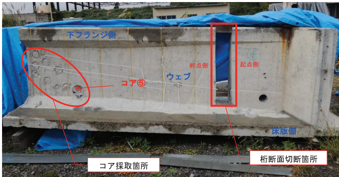
写真-3.1.5 解体調査状況 (C-6)
