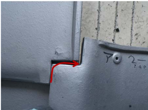
写真 5.3.7 火の粉の侵入経路
