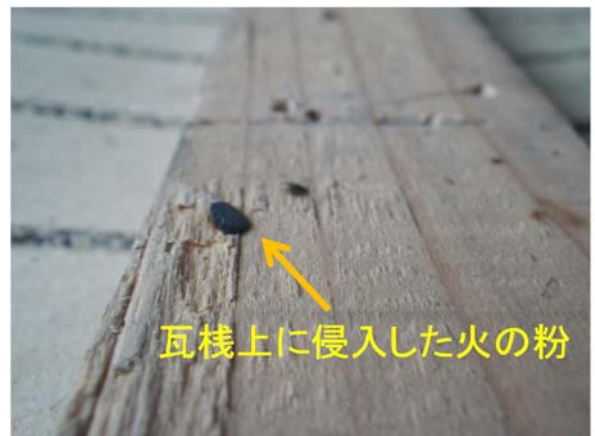
写真 5.3.8 屋根下地で確認された火の粉
