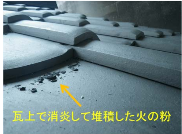
写真 5.3.6 瓦上部で消炎して堆積した火の粉
