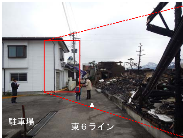
写真 3.2.3.8 東 6 焼け止まり線の焼け止まり線 (北側から撮影。右側は全焼した⑮飲食店)
