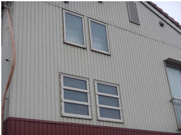
写真 3.3.12.3 網入りガラスの亀裂
