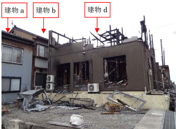
写真 3.3.9.2 建物 d の 1 階外壁の燃え残り
