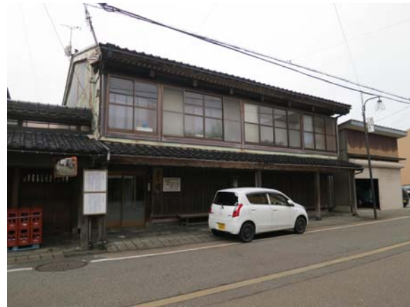
写真 2.3.2 焼損区域周辺の建物
