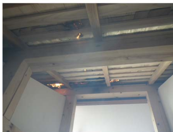
写真 5.3.4 実験中の屋内側の状況
