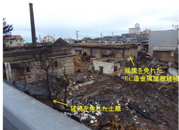
写真 3.3.11.2 延焼後の敷地の様子
