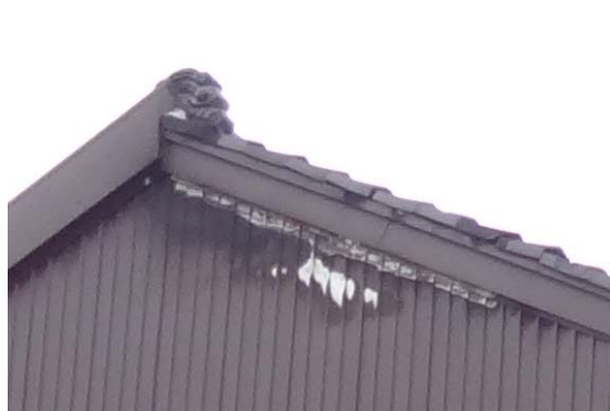
写真 3.3.6.2 西妻面の様子
