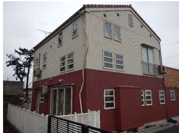
写真 3.3.12.2 戸建住宅の南東側の状況
