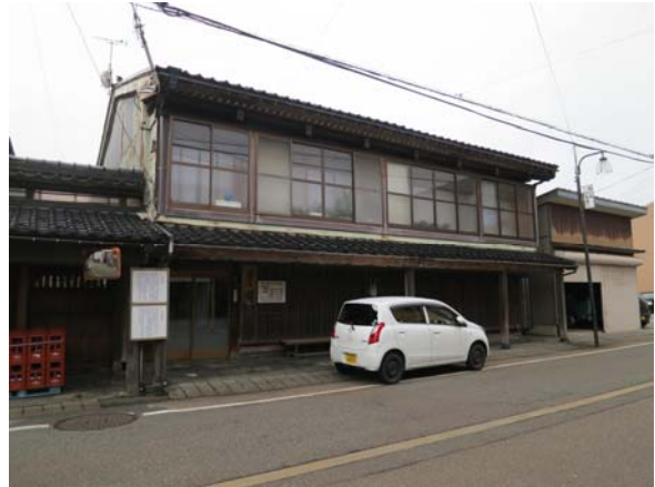
写真 2.3.2 焼損区域周辺の建物
