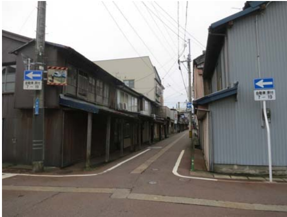
写真 2.3.1 焼損区域周辺の建物
