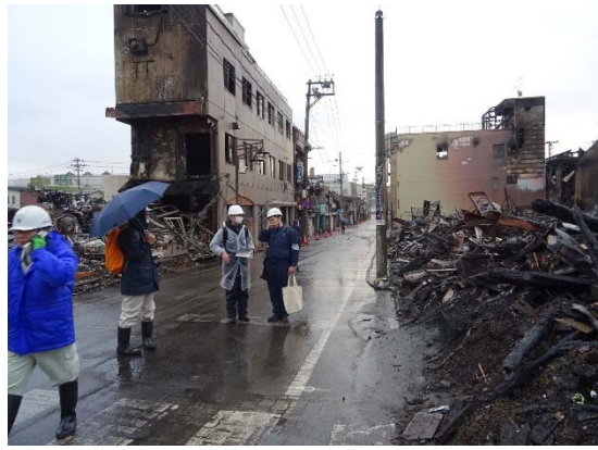
写真 3.1.4 火元建物より北側の仲道線の様子
