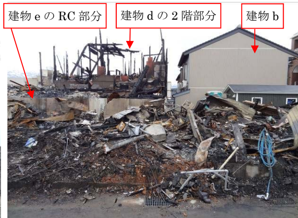
写真 3.3.9.3 建物 b 北側の火災跡と外壁面
