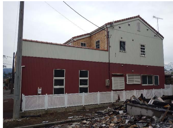
写真 3.3.12.4 戸建住宅西側の状況
