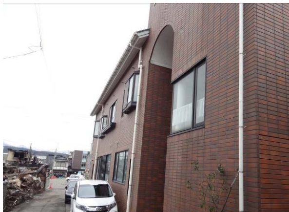
写真 3.3.7.2 東側道路の様子
