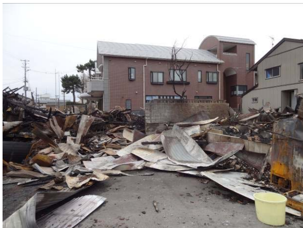
写真 3.3.7.1 東から見た外観
