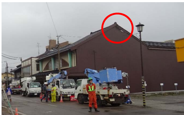
写真 3.3.6.1 北西から見た外観
