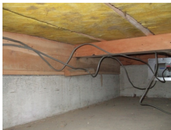
写真 6.3.2 在来軸組構法による 1 階床下例（左：布基礎 右：ベタ基礎）
