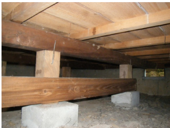
写真 6.3.2 在来軸組構法による 1 階床下例（左：布基礎 右：ベタ基礎）
