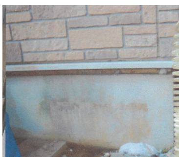
外張基礎断熱の側面の汚損状態
