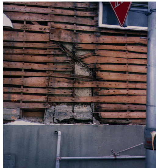
写真 1.1.1 阪神淡路大震災において見られたモルタル外壁被害と構造部材の腐朽・蟻害例
