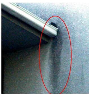
軒樋端部の雨垂れは要補修 軒裏の結露か雨漏れの兆候
