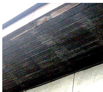
軒樋端部の雨垂れは要補修 軒裏の結露か雨漏れの兆候
