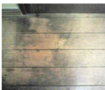
床裏の結露により表面が黒く変色
