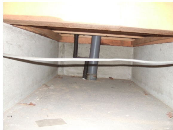
写真 6.3.4 1階床下配管の様子
