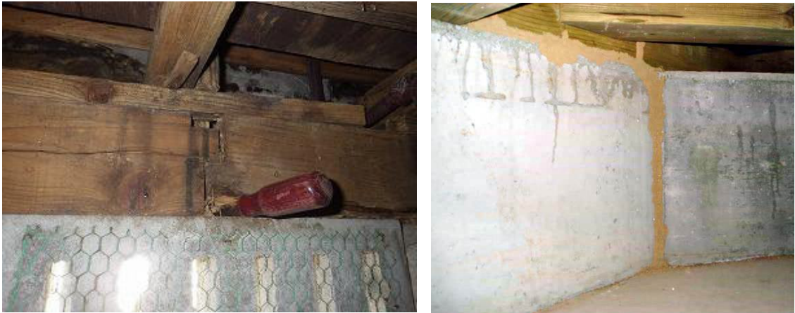
写真 6.3.3 左：土台下部の腐朽例 右：基礎立ち上がり部分に蟻道が構築され土台に達している例
