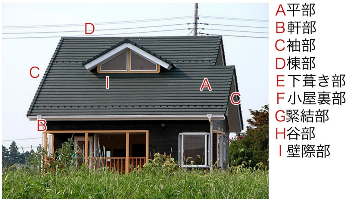
写真 3.1.5 プレスセメント瓦の部位説明
