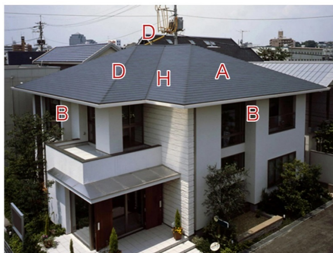
写真 3.1.3 住宅屋根用化粧スレートの部位説明
