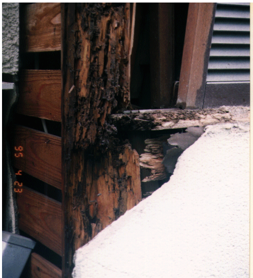
写真 1.1.1 阪神淡路大震災において見られたモルタル外壁被害と構造部材の腐朽・蟻害例
