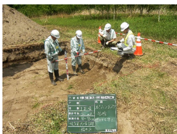
埋め立て厚の確認
