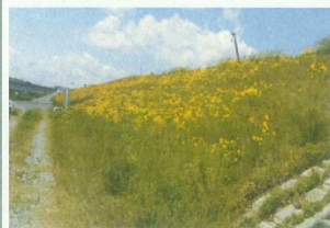
堤防 川表側(除草前撮影)
