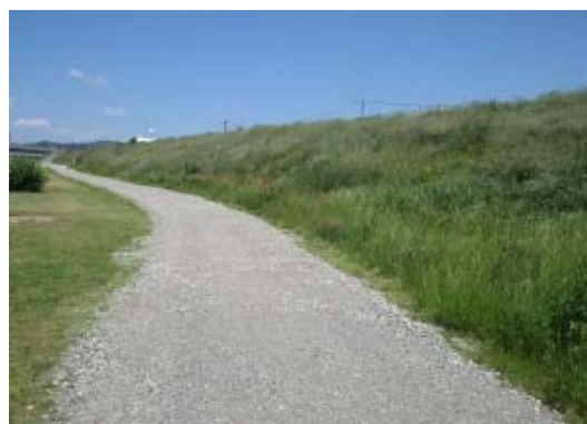
防除対策実施後（H27.5）
