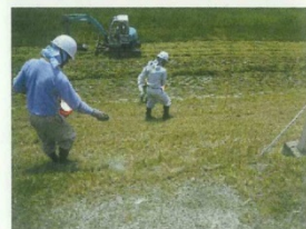
旭川での試験施工の様子(H24年度)
