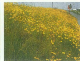
堤防 川裏側(5月撮影)
