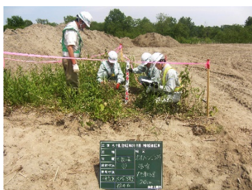
すきとり状況
