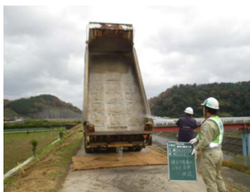
ダンプトラック洗浄状況
