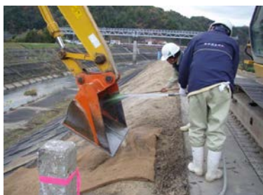
バケット洗浄状況
