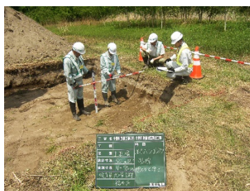
埋め立て厚の確認
