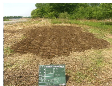
防除対策完了
