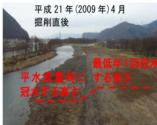
掘削直後の状況
