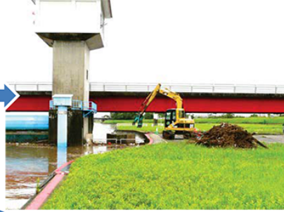
かなりの重量のため建設機械で引き上げます。
