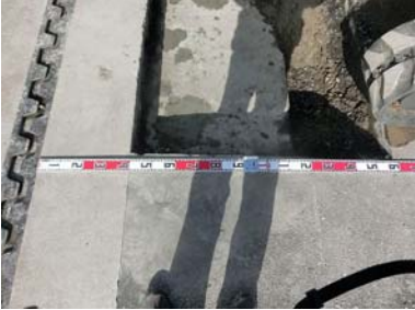
A2 試掘部（床掘部・舗装部）
