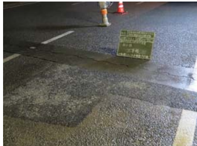
A1上流側 路面復旧（床掘部・舗装切削部）
