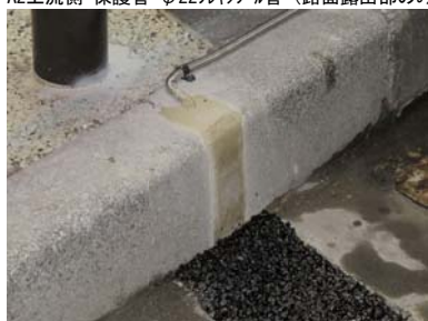
A1下流側 排水溝
