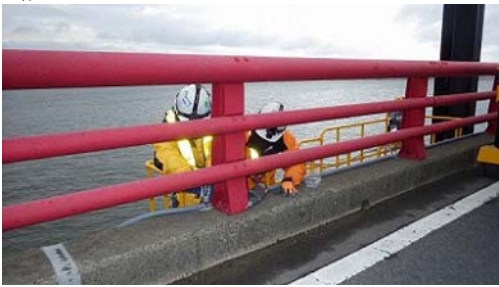
配線ケーブル
