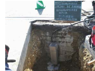
A2 橋台背面盛土部測装置（鉛直方向沈下計測）
