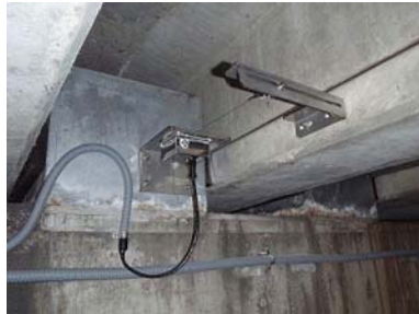
橋台部 橋軸方向 桁端部支点部計測装置
