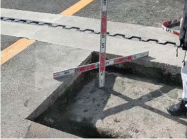
A2 試掘部（床掘部）
