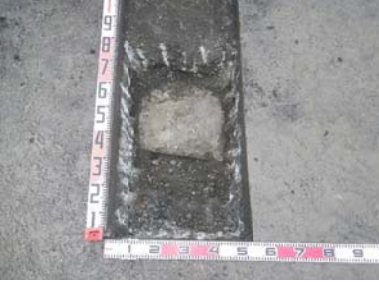
A1 試掘部（床掘部） 復旧：常温合材使用
