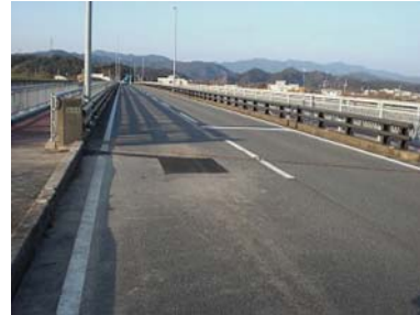
A2 路面復旧（床掘部、路盤工剥取）
