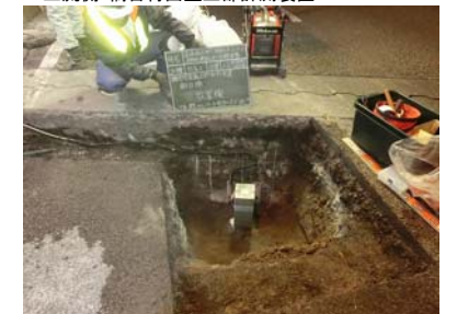
A2桁側面 桁端部支点部計測装置 (橋軸方向)
