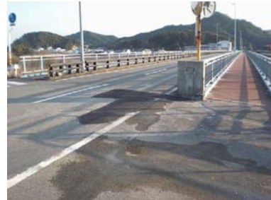
A2 路面復旧（床掘部、路盤工剥取）
