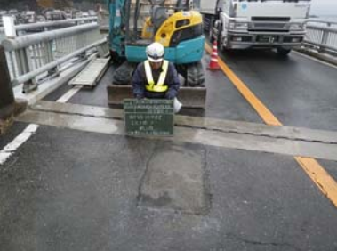
A1 桁端部支点部計測装置（橋軸方向計測）
