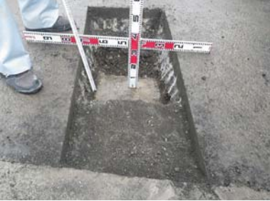
A1 試掘部（床掘部）
