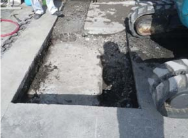
A2 試掘部（床掘部・舗装部） 復旧：常温合材使用
