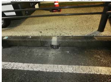
A2上流側 保護管 φ22フレキシブル管（路面露出部のみ）
