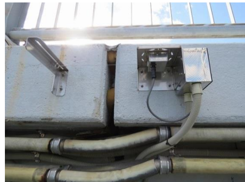
写真 3-6 地覆部設置事例
