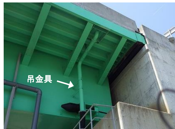
写真 3-8 鋼床版箱桁橋
