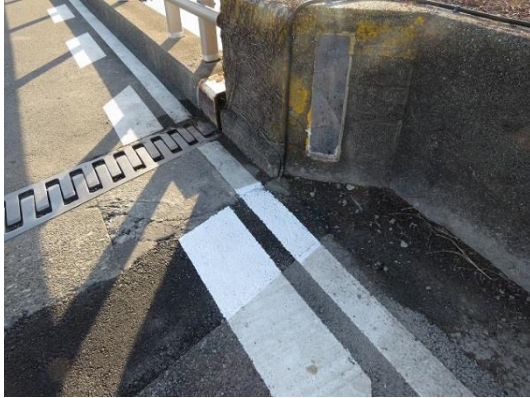
写 3-20 橋台背面配線事例（壁高欄）
