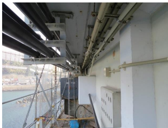
写 3-30 補修工事の足場を利用した設置
