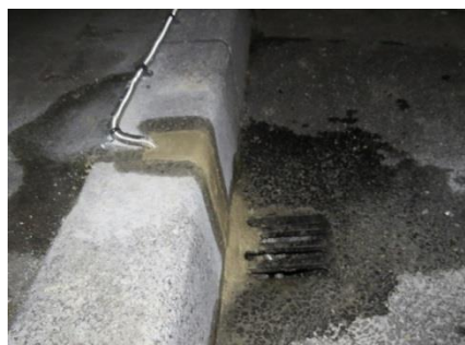
写 3-10 歩車道境界部 溝掘り復旧事例
