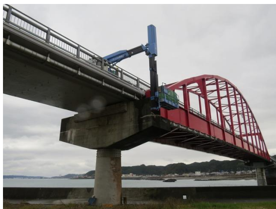
写 3-29 点検車による設置
