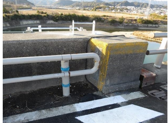
写 3-21 橋台背面配線事例（壁高欄）
