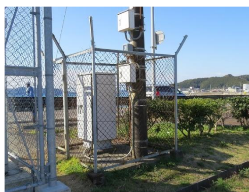
写 3-27 引き込み柱（監視カメラ）から引電事例
