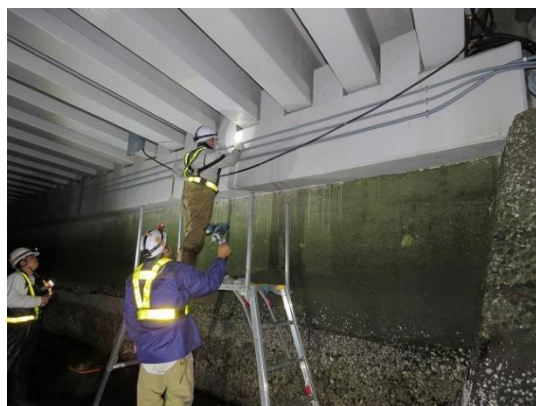
写 3-31 簡易足場による設置
