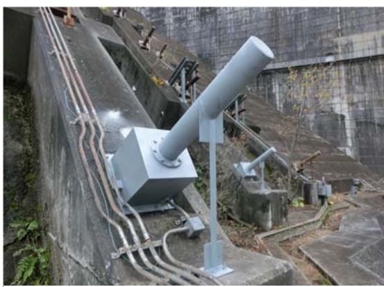
図 参 1.14 再設置した頭部キャップ（Mダム）
