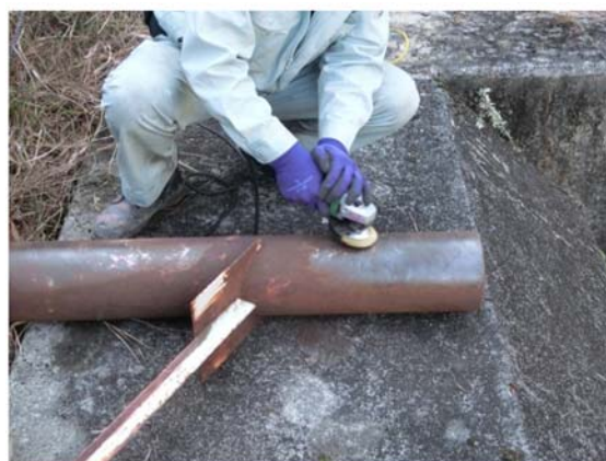
図 参 1.13 頭部キャップの錆落とし（Mダム）
