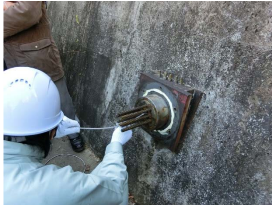
図 3.17 工業用内視鏡による調査状況 (アンカーヘッドに設けられた貫通孔を利用して内視鏡を挿入している)
