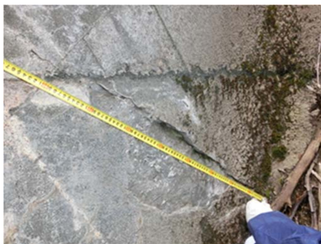
図 参 1.5 現場打ち法枠に確認されたクラック（Mダム）
