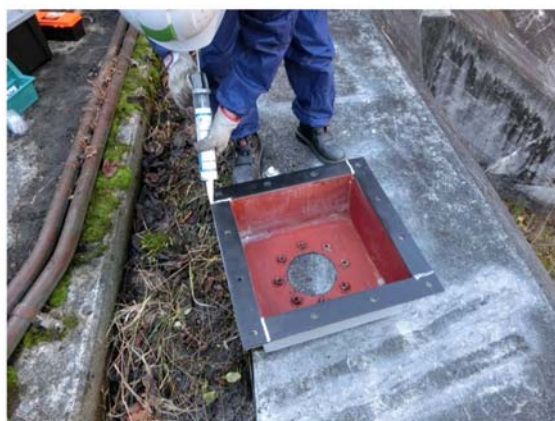
図 参 1.12 止水ゴムの交換 (Mダム)
