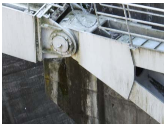
図 3.7 ゲート固定部における 水分の浸み出し、防錆材の流出跡
