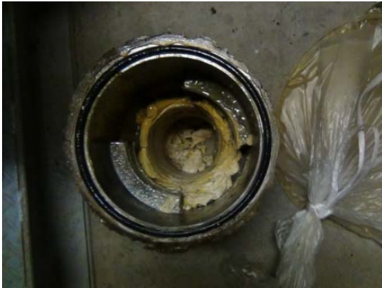
図 3.11 防錆材の色相の変化 (白色、白濁色：水の浸入による乳化現象で劣化)
