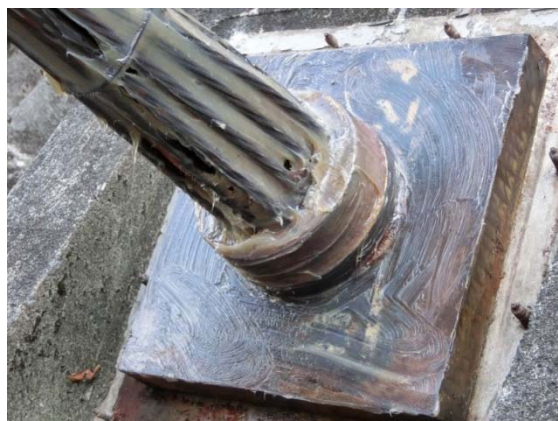
図 参 1.11 防錆材を塗布した支圧板 (Mダム)
