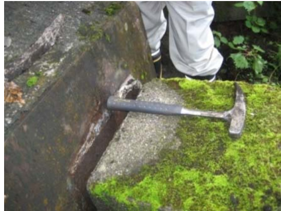
図 3.3 頭部コンクリートの浮き上がり (受圧構造物からの剥離) 18)
