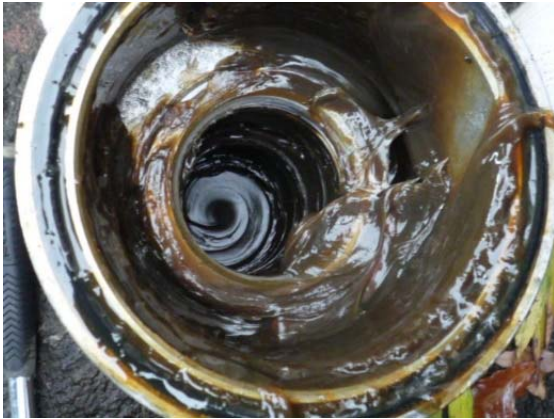
図 3.13 防錆材の色相の変化 18) (黒色：劣化物生成)
