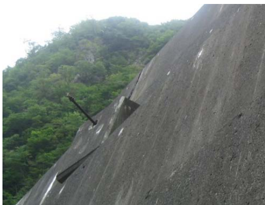
図 3.8 遅れ破壊により破断し飛び出したアンカーの事例 18)
