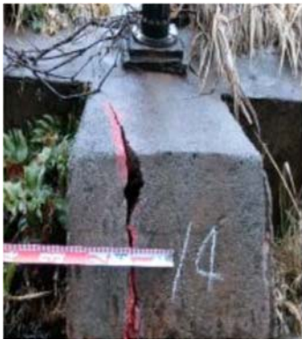
図 3.4 受圧構造物（法枠）に 確認されたひび割れ 18)
