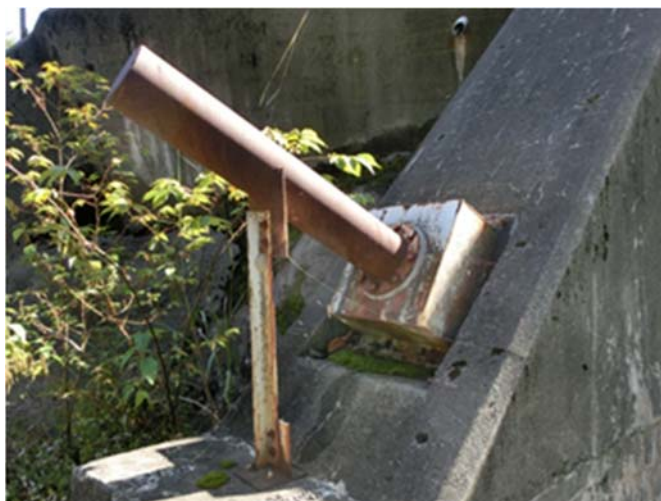
図 参 1.6 塗装がほとんど剥がれ錆が確認された頭部キャップ（Mダム）
