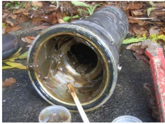
図 3.14 背面から水が浸入したことによる 防錆材の流出 18)
