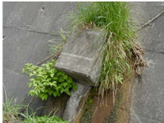
図 3.5 水分の浸み出しによるものと 想定されるアンカー周辺の植生繁茂 18)
