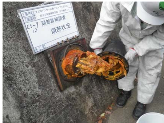
図 3.12 防錆材の色相の変化 (赤褐色：錆の発生)
