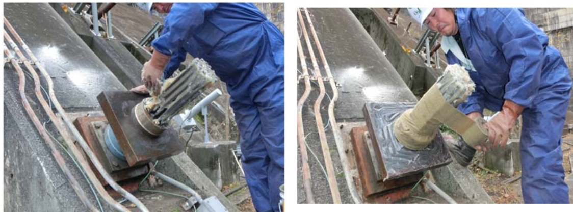
図 参 1.10 アンカーにおける詳細調査終了後の対応(左：防錆材の塗布、右：防錆テープの巻き付け) (Mダム)
