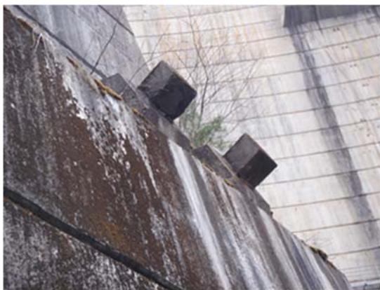
図 3.6 頭部コンクリート周辺の遊離石灰 18)
