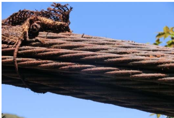
図 参 1.8 アンカー頭部で確認された錆 (Mダム)
