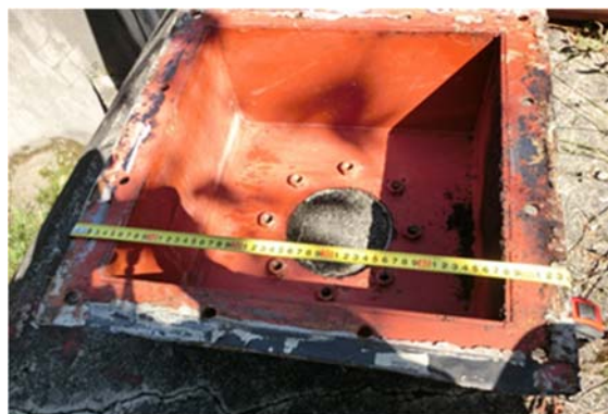
図 参 1.9 頭部キャップの止水ゴムの劣化 (Mダム)
