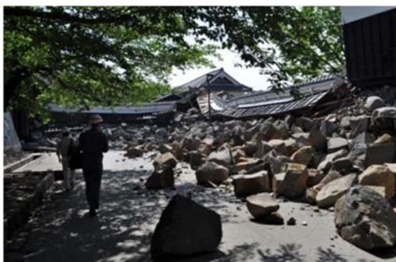
写真-9.1 石垣の大規模な崩落（熊本城公園、5月17日）（左）
