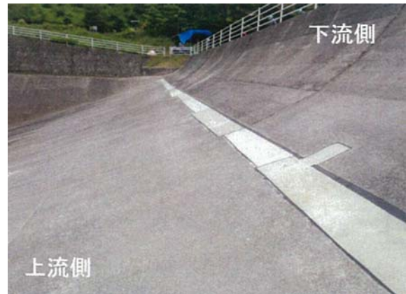
写真-6.10 コンクリート表面遮水壁の復旧状況(地蔵原ダム) (九州電力(株)提供資料)
