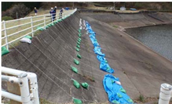
写真-6.1 コンクリート表面遮水壁部の状況 (地蔵原ダム堤体上流面) ※ブルーシートは雨水浸入防止のための応急対策用
