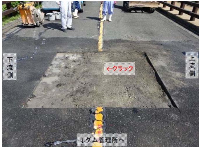
写真-6.19 天端舗装を剥いでのクラック確認状況(緑川ダム脇ダム) (九州地方整備局提供資料)
