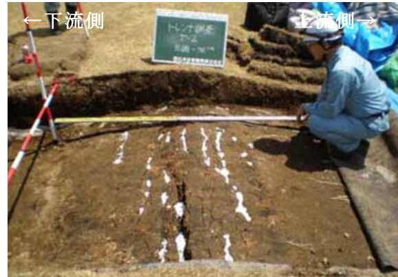
写真-6.12 クラックへの石灰ミルク注入 (地蔵原ダム) (九州電力(株)提供資料)
