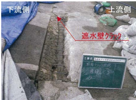
写真-6.9 コンクリート表面遮水壁部クラックのはつり調査(地蔵原ダム) (九州電力(株)提供資料)
