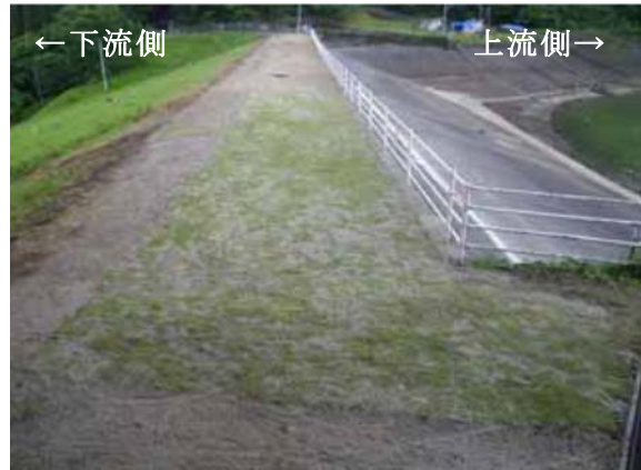
写真-6.18 天端応急復旧後の状況 (地蔵原ダム) (九州電力(株)提供資料)
