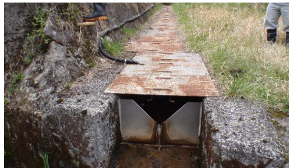
写真-6.6 漏水計測状況(地蔵原ダム堤体下流法尻)
