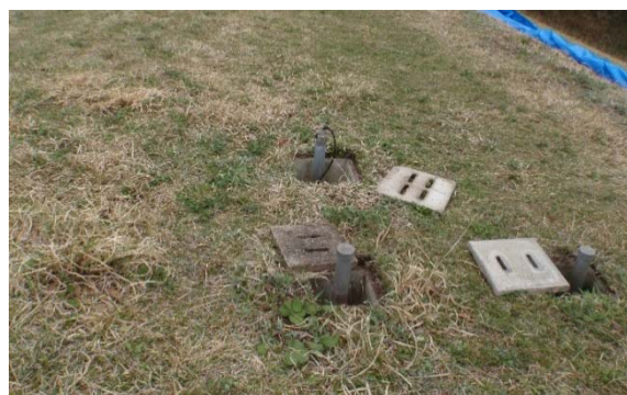
写真-6.4 堤体内水位観測孔パイプの浮き上がり(地蔵原ダム天端)
