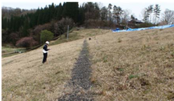
写真-6.5 堤体下流面(地蔵原ダム)
