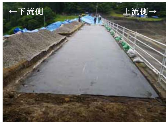
写真-6.16 遮水シート設置状況 (地蔵原ダム) (九州電力(株)提供資料)
