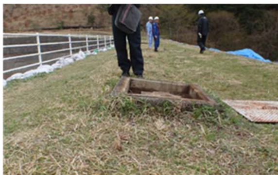
写真-6.3 測量標点基礎コンクリートの浮き上がり(地蔵原ダム天端)
