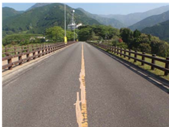
写真-6.7 縦断クラックが発生した堤体天端部の状況(緑川ダム脇ダム)
