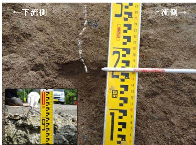
写真-6.21 トレンチ掘削によるクラック確認状況(緑川ダム脇ダム) (九州地方整備局提供資料)
