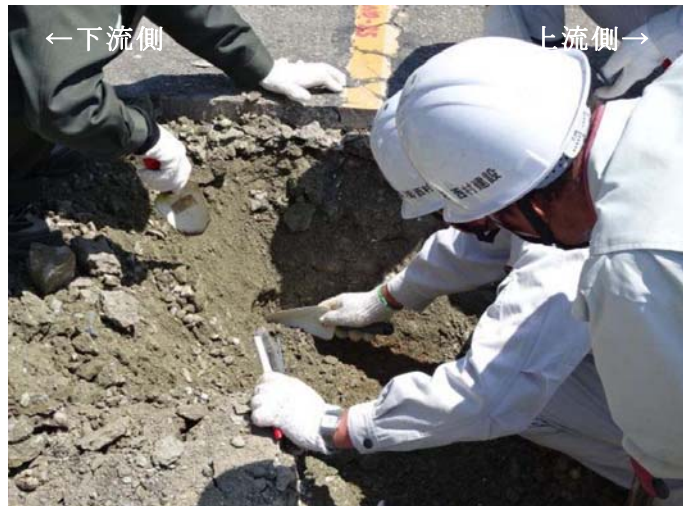
写真-6.20 トレンチ掘削状況(緑川ダム脇ダム)(九州地方整備局提供資料)
