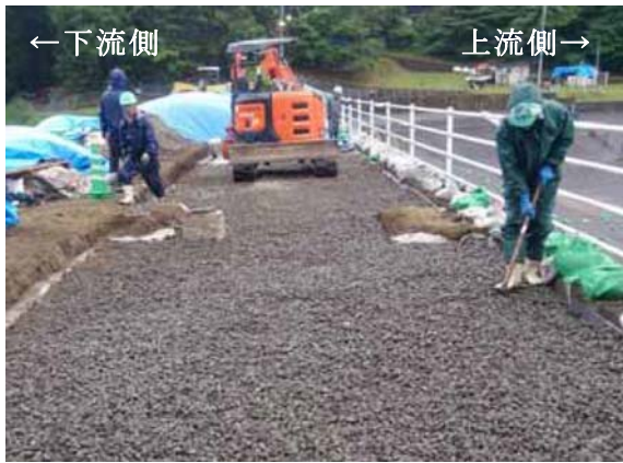
写真-6.17 砕石敷設状況(地蔵原ダム) (九州電力(株)提供資料)
