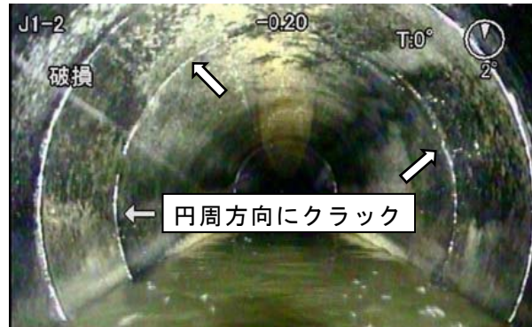
(b) 下水道管の破損
