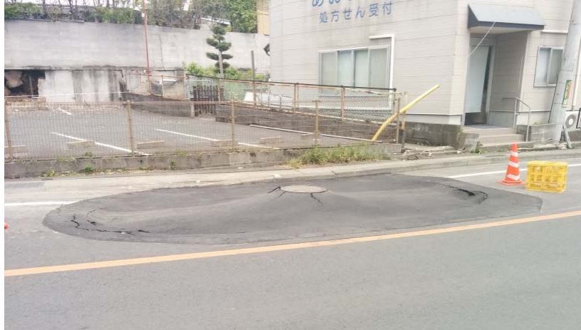
写真-4.3 県道28号線（惣領付近）周辺の状況
