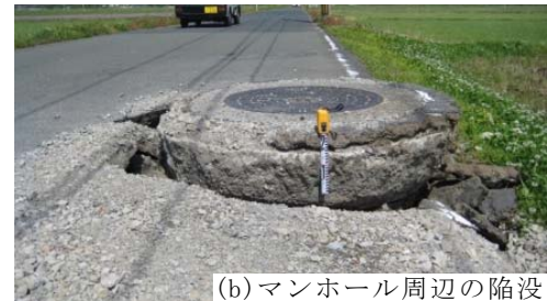
(b) マンホール周辺の陥没
