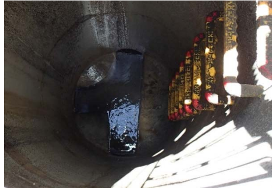
(b)マンホール内の滞水
