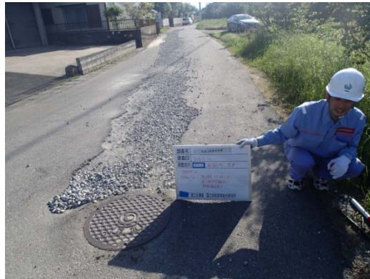
写真-4.8 埋め戻し部の路面陥没（仮復旧後）（熊本市富合町榎津）
