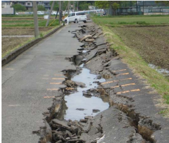
(a) 路面の陥没
