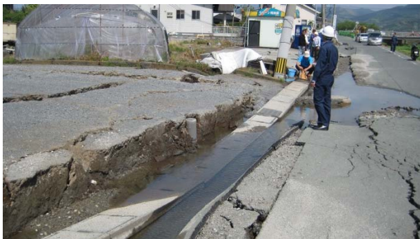
(a) 秋津川沿いの堤防盛土崩壊
