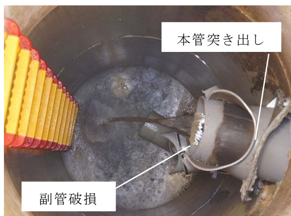
(b) 本管突き出しと副管損傷
