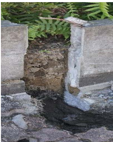
(a)擁壁の破損・ズレ
