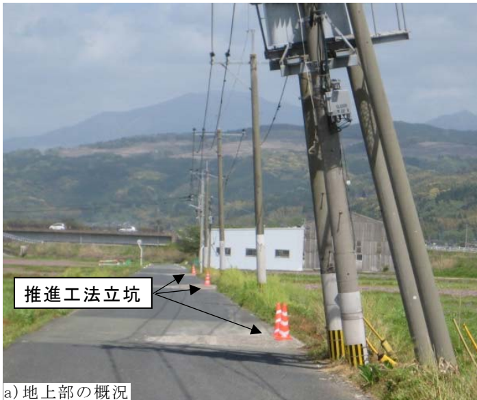
写真-4.2 推進区間で発生した被害の状況
