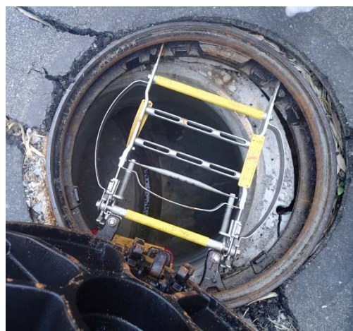
(b)マンホール蓋受け枠ズレ
