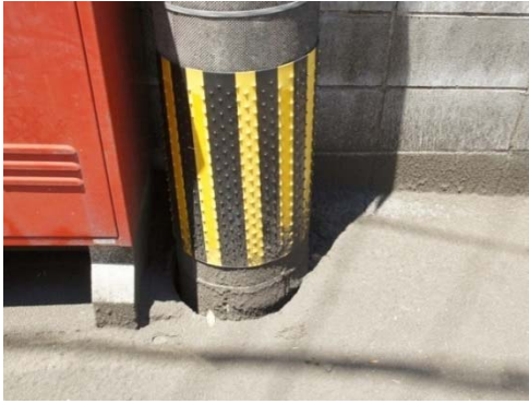
(a)液状化による電柱の沈下
