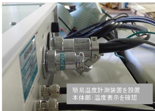
図-4.13 簡易温度計測装置による点検
