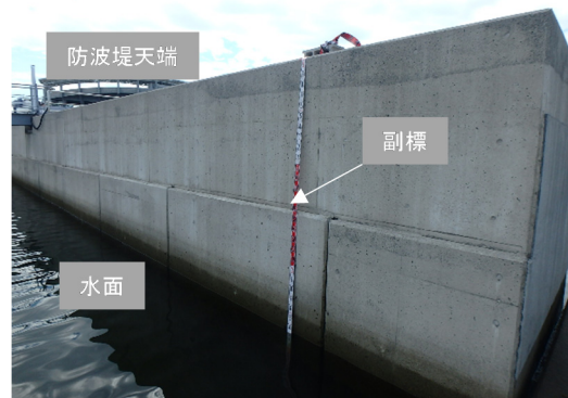
図-3.1 海水面の測定（港内側）
