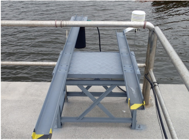
写真-B.1 架台設置 (左側：取付金具取換後)
