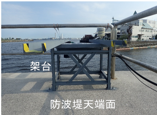
写真-B.2 取付架台の設置 (港内側より撮影)
