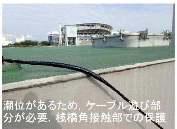
写真-B. 12 浮栈橋部ケーブル設置
