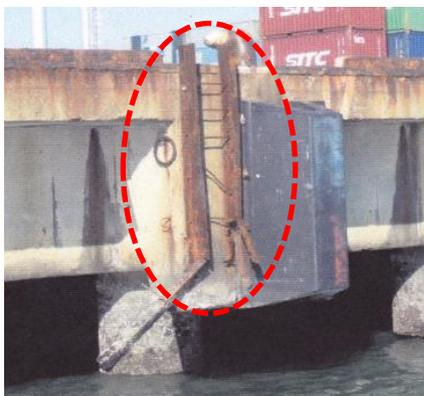
図 4.29 岸壁側面に突出したはしご
