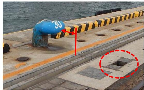
図 4.5 荷役機械用の溝や箱抜きの近接
