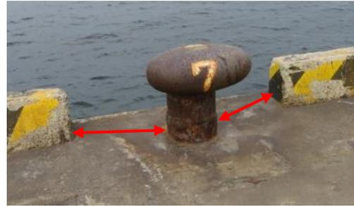
図 4.18 車止めの係船柱からの離隔
