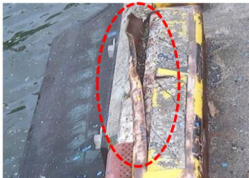
図 4.36 鋼材が腐食した車止め
