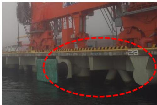
図 4.32 繋船ボートの潜り込み防止がない岸壁
