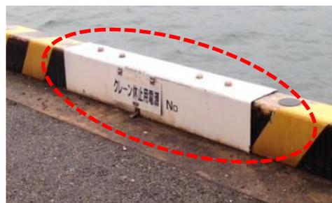
図 4.26 車止めと一体化した電源ボックス (安全性向上事例)
