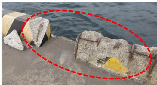
図 4.35 天端が欠けた車止め
