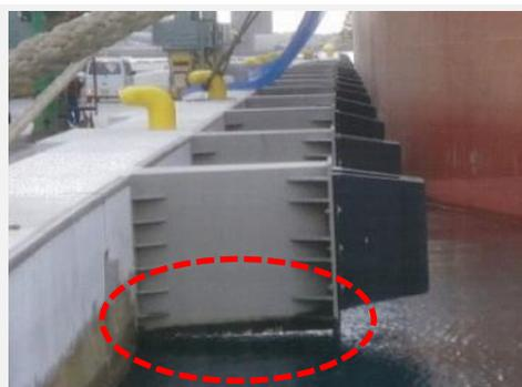
図 4.16 防舷材の鋼製の台座
