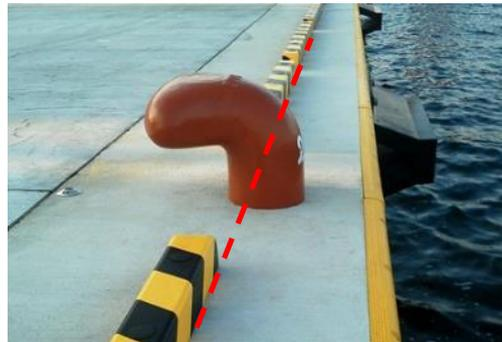
図 4.19 車止めを係船柱の陸側に配置 (安全性向上事例)
