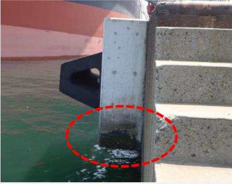
図 4.17 防舷材のコンクリート製の台座
