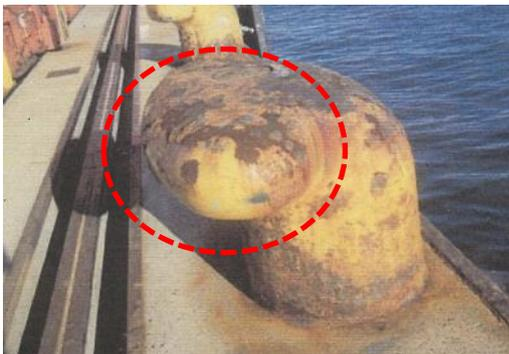
図 4.9 係船柱の頭部の出幅
