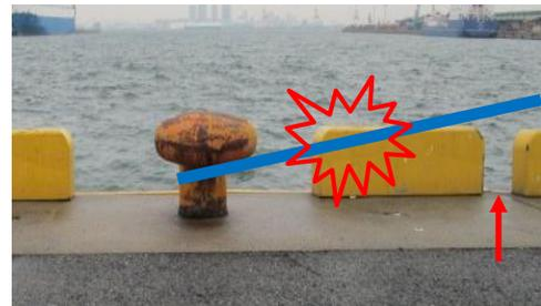
図 4.20 車止めの高さ及び端部の角張り・車止めの間隔
