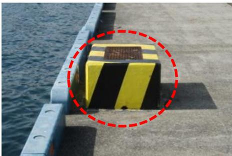
図 4.27 岸壁上に突出した給水設備
