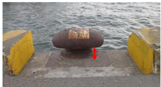
図 4.10 係船柱の胴部の高さ
