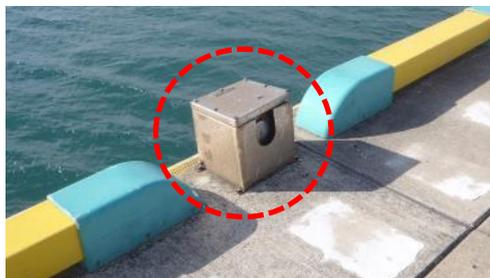
図 4.25 岸壁上に突出した電源ボックス
