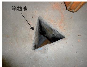
②箱抜き型枠の撤去
