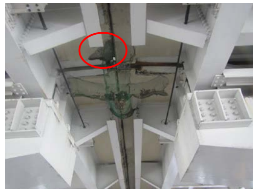
(b) コンクリート片とともに落下防止対策が一緒に落下
