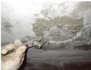
⑧断面修復材充填 左官作業
