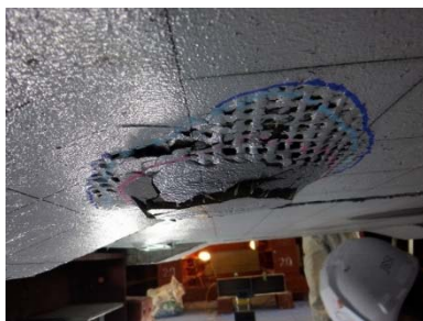
固定モルタル破損時
