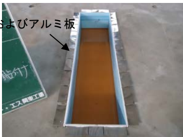
③発泡型枠の設置
