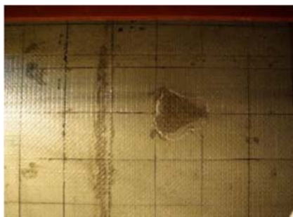
①固定モルタル破損時
