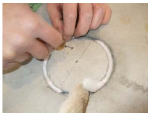
④離隔調整材 (φ13mm) 上面側より2重目設置
