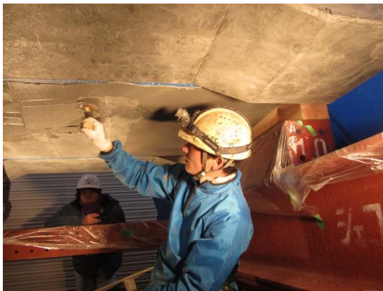
(a) 貼付モルタル下塗り
