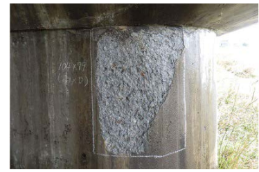
(f) 橋脚柱部 (形状: 台形)
