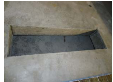
②箱抜き型枠の撤去
