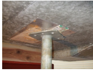
②復旧コブ仮受け
