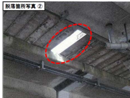
(d) 設置部材の落下
