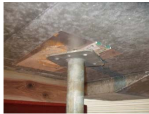
②復旧コア仮受け
