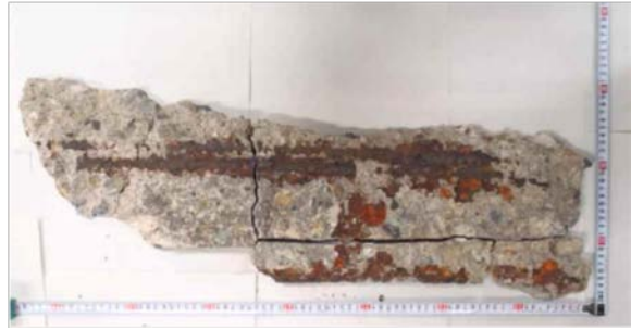
(b) コンクリート片の落下（錆汁が見られる例）
