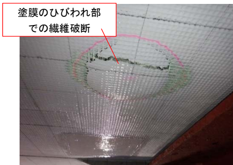
④繊維(1方向目)の破断
