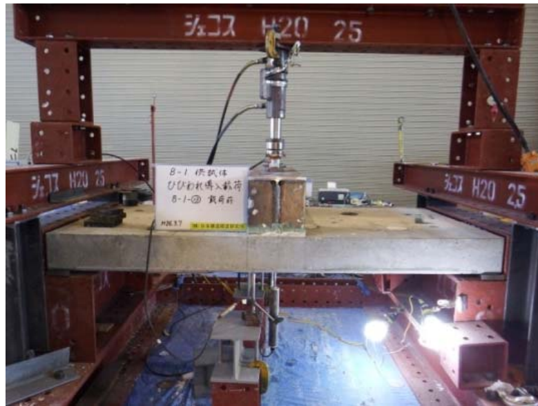
図 4.4.6 曲げひびわれ発生作業状況
