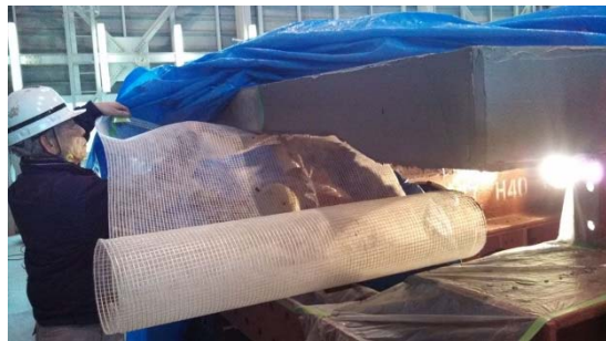
(b) メッシュシート貼付け
