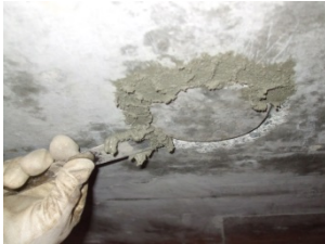
⑧断面修復材充填 左官作業
