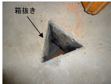
②箱抜き型枠の撤去
