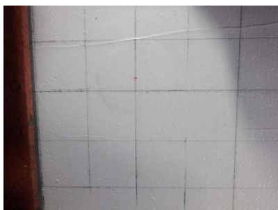
①固定モルタル破損時
