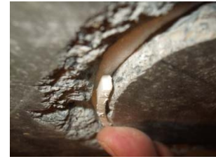
⑥離隔調整材設置位置調整
