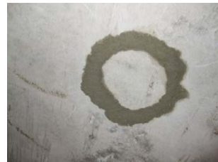
⑨断面修復材充填完了
