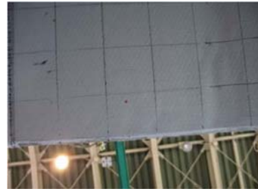
(a) 固定モルタル破損時
