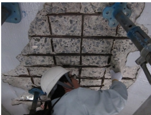
(c) 表面塗装等と一緒にコンクリート片が落下
