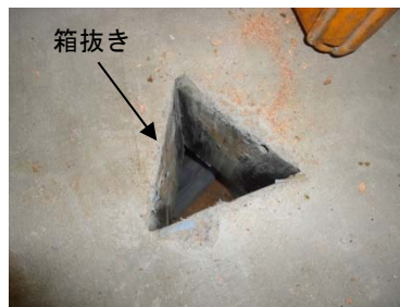
②箱抜き型枠の撤去
