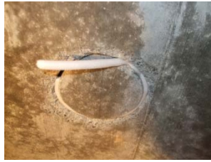
⑤離隔調整材 (φ8mm) 下面側より設置
