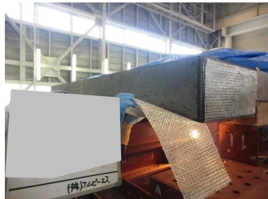
(b) 繊維シート貼付け
