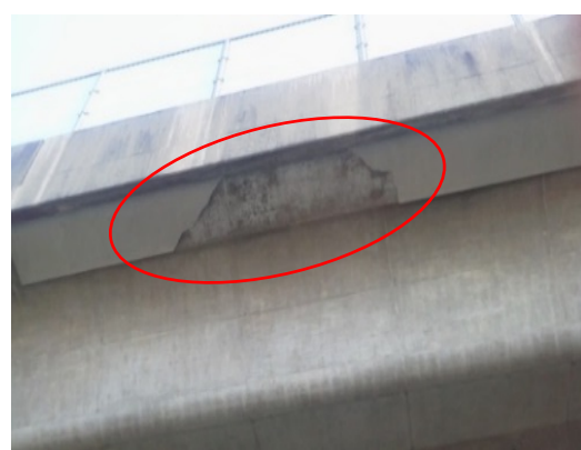
(c) 表面塗装等と一緒にコンクリート片が落下
