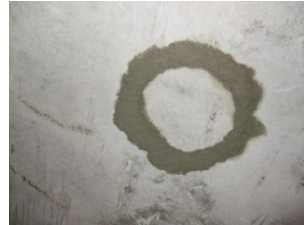
⑨断面修復材充填完了
