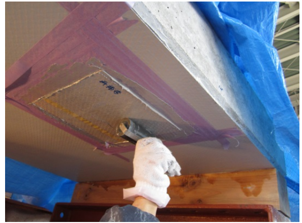
(b) 切り欠き部に対する施工(補修)
