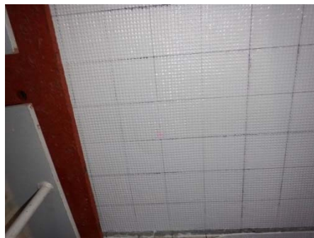
①固定モルタル破損時
