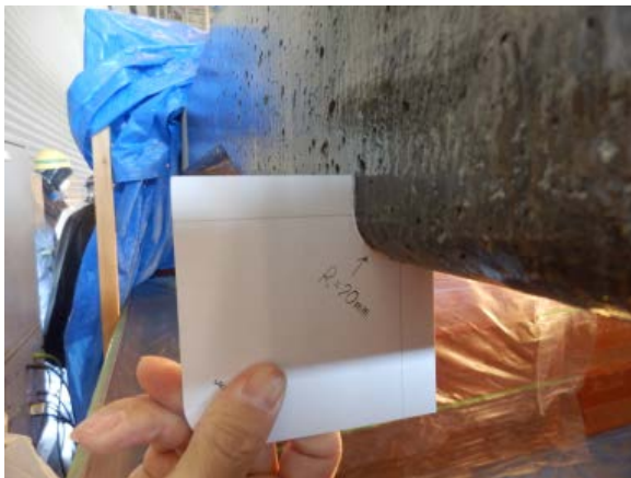
(a) 角部面取り状況
