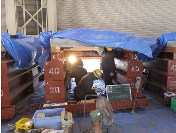
(a) 施工状況（架台設置）
