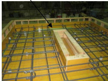
①箱抜き型枠の設置
