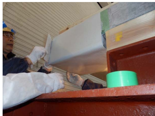
(b) ラミネートシート貼付け
