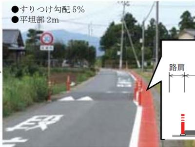
図 3-10. 設置した高さ 7cm の凸部 (つくば市)
