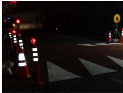
図 4-1. 反射材の使用例
