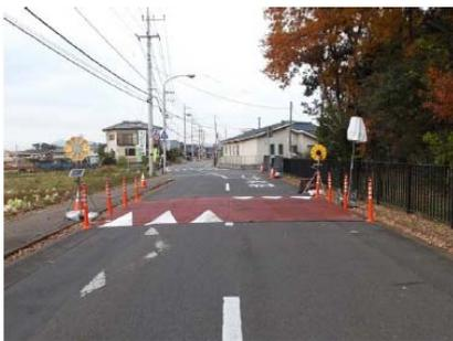
図 3-8. 設置した高さ 10cm の凸部 (つくば市)
