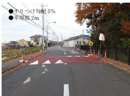
図 3-35. 設置した高さ 10cm の凸部 (つくば市)
