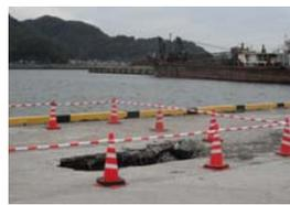
コンクリートの欠損、陥没等
