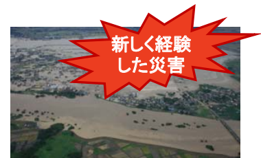
関東・東北豪雨における鬼怒川洪水氾濫(H27.9)
