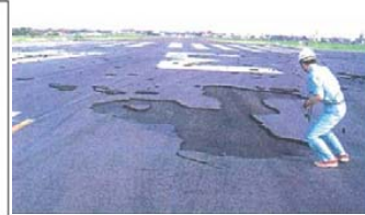
滑走路大規模破損の例 (2000年7月 名古屋空港)
